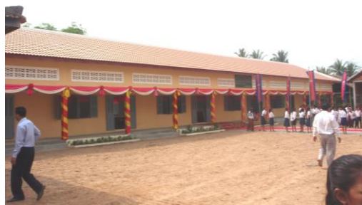
完成した 4 教室の校舎
