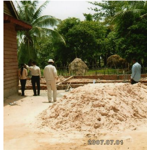
タットム校新校舎建築現場
