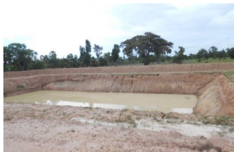
学校裏に掘られた巨大な貯水池
